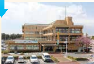
▲さらに増築された現在の役場庁舎
