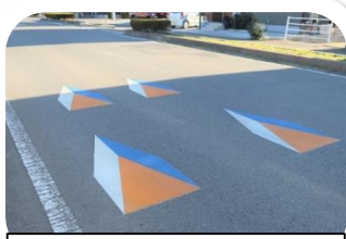
減速を促す路面標示
