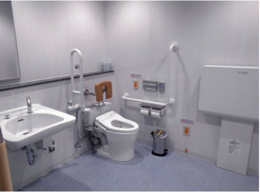
改修した竹来中学校多目的トイレ
