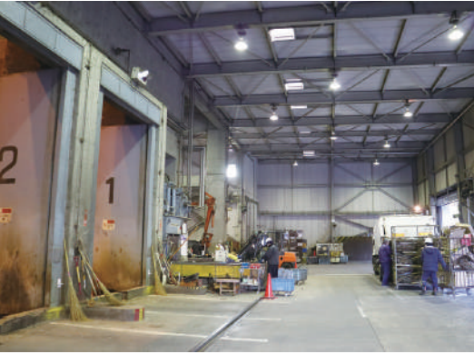
霞クリーンセンター内部
