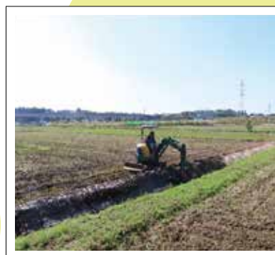
水路の泥上げ
