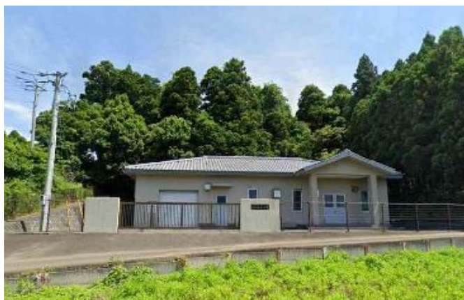
追原中継ポンプ場
