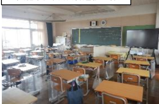
R06実施予定箇所(普通教室棟)
