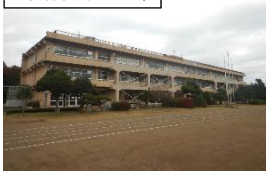
R06実施予定箇所(全景)
