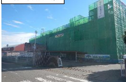
R05施工箇所(全景)
