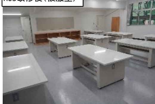
R05改修後(被服室)
