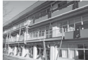
外壁・屋上防水改修工事を行った阿見中学校
