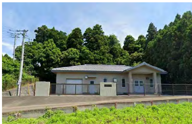
追原中継ポンプ場
