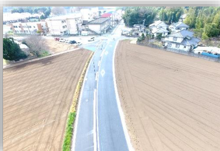
3. 「暮らしを支えるまちづくり」を実現するための事業 (本郷小学校につながる町道を新設しました)
