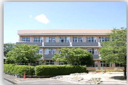
2. 「人を育むまちづくり」を実現するための事業 (竹来中学校の外壁改修工事を実施しました)
