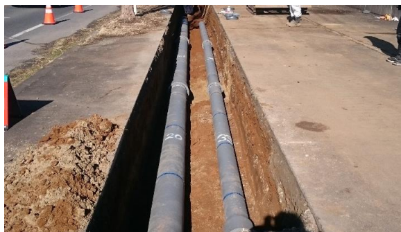
配水管路工事状況
