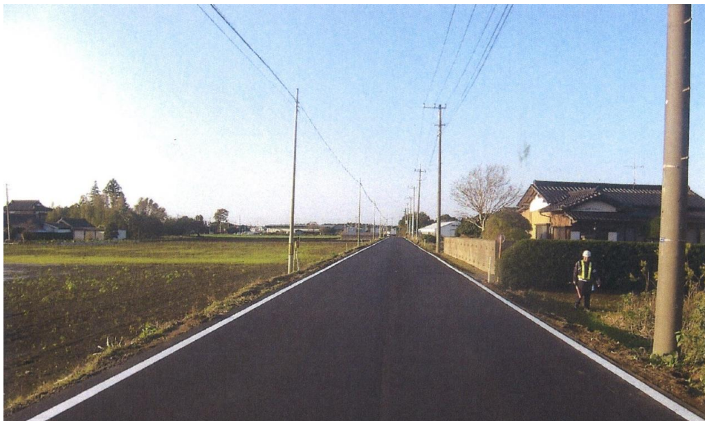
令和元年度施工例:下小池地内の道路舗装補修工事
