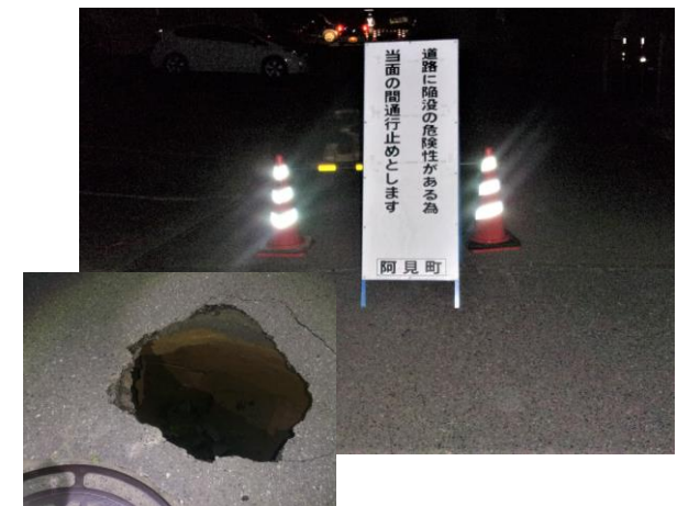
道路障害対応－陥没の例
