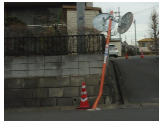
カーブミラーの破損
