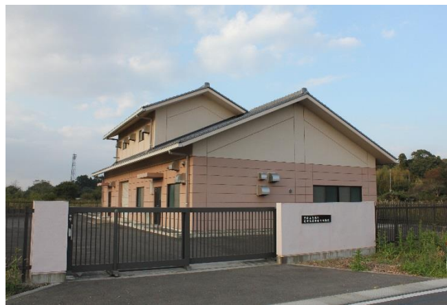
実穀上長地区農業集落排水処理施設
