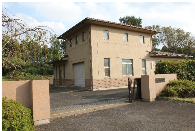
君島大形地区農業集落排水処理施設
