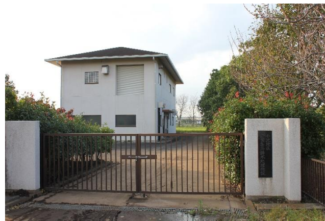
小池地区農業集落排水処理施設
