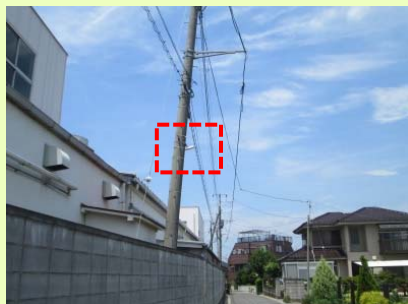
防犯灯取付箇所
