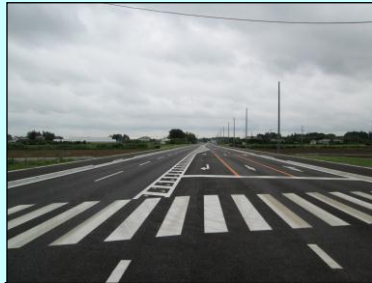
都市計画道路荒川沖・寺子線整備
