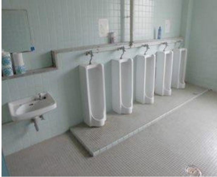
本郷小学校トイレ現況
