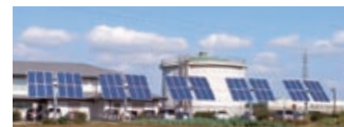
水道事務所敷地内に設置された追尾式太陽光発電
