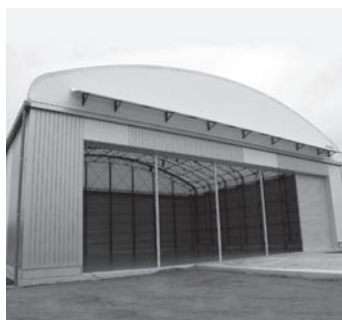
▲建設中の格納倉庫
