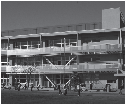
▲耐震工事の完了した校舎
