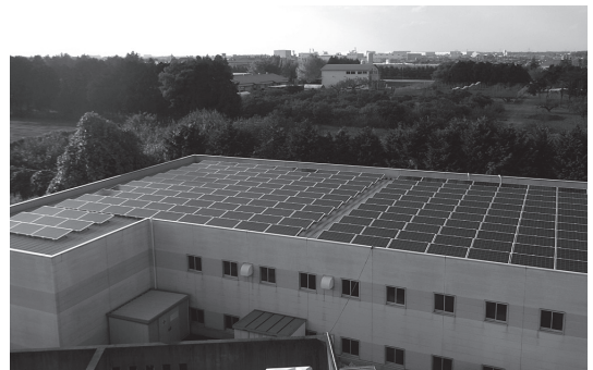
▲太陽光パネルが敷かれた役場車庫の屋根
