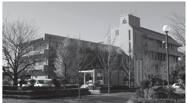
▲3 旧庁舎 (写真:左側棟) と 2 新庁舎 (写真:右側棟)
