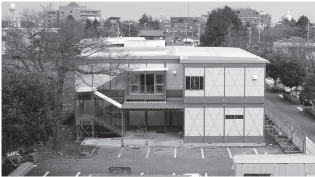
▲1 仮設庁舎 (出入口側)
