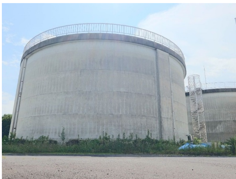
図 3-4.上郷配水場PC配水池
