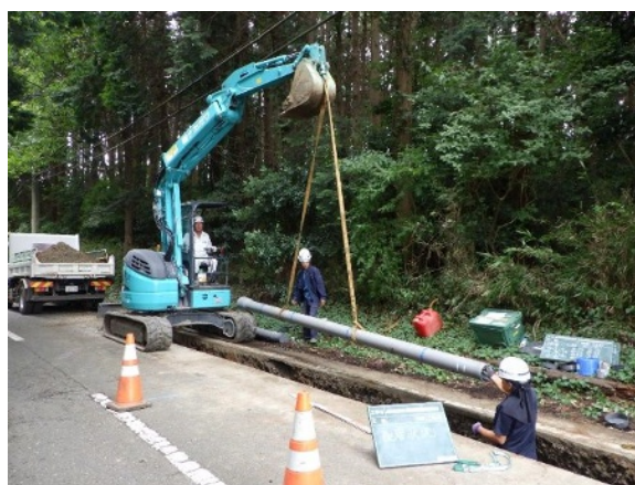
図 5-3.水道管の布設工事
