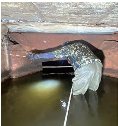
▲ 雨水管潜行目視調査の様子
