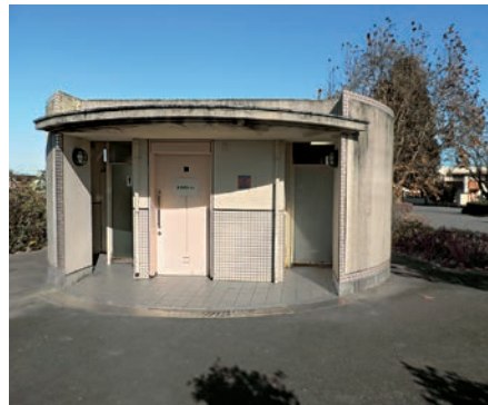
▲役場駐車場北側にある公衆トイレ
