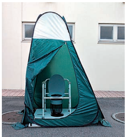
▲マンホールトイレ
