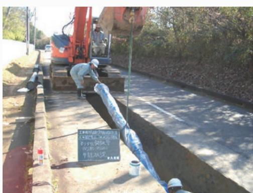
▲水道の耐震管布設工事
