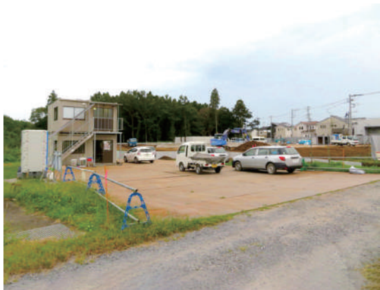
▲荒磯部屋新築工事
