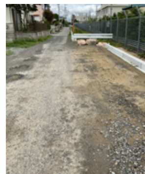
二区南地内道路改築工事の現場
