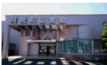
改修予定の阿見町図書館
