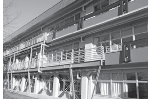
外壁・屋上防水改修工事を行った阿見中学校
