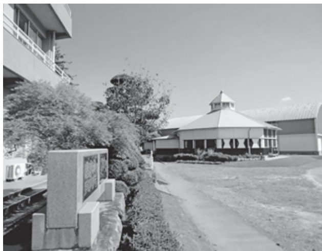
君原小学校図工室棟
