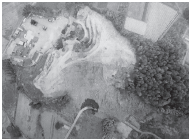
残土崩落流出事態（令和2年4月23日）
