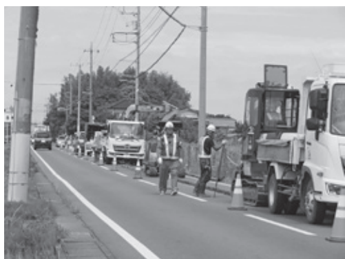
工事中の三区上
