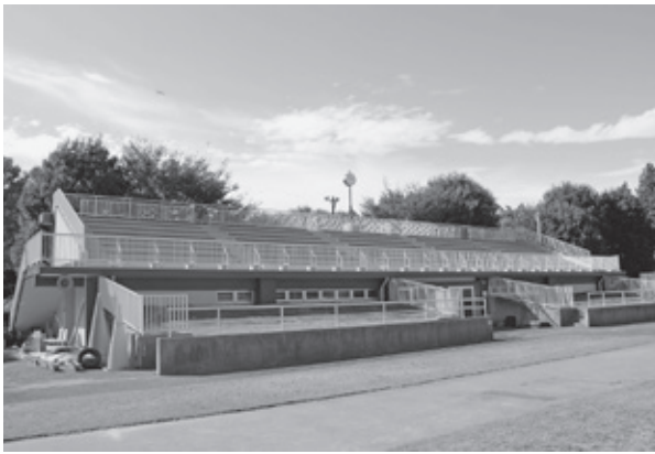
改修工事を実施した陸上競技場スタンド
