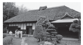
古民家山中家住宅
