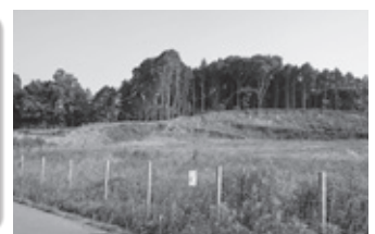
伐開工事が完了した現在検討中の道の駅建設予定地
