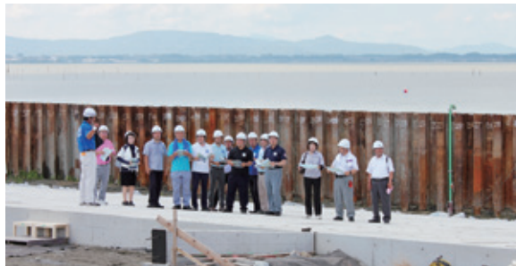
国体特設会場整備工事見学会の様子(7月9日)
