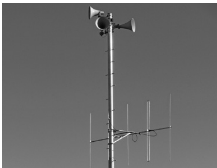
平成27年度に設置された防災行政無線
