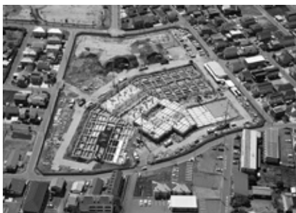
本郷地区の新小学校建設現場 (4月13日)
