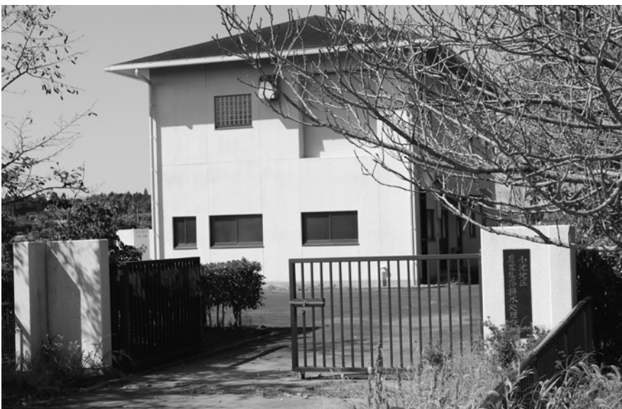
小池地区農業集落排水施設
