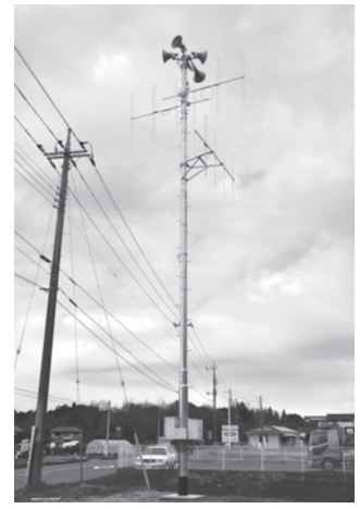
防災行政無線放送施設
