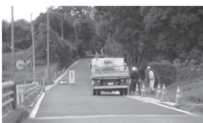
整備が進む中根・実穀間の町道
