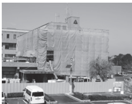
現在行われている役場庁舎耐震工事
