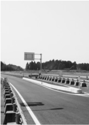
昨年12月に開通した追原・久野線と阿見吉原土地区画整理事業地内の造成状況
