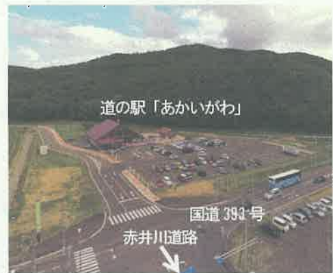
至赤井川市街 至倶知安 写真:小樽開発建設部
