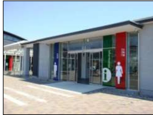
参考：情報施設兼トイレ（道の駅しもつけ） 情報施設とトイレが一体となっている。
