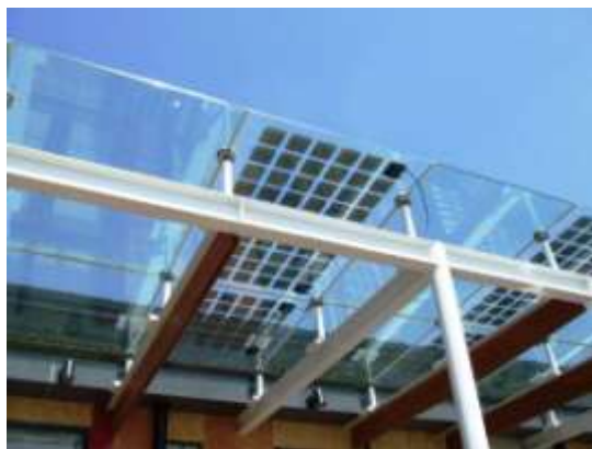
屋根の太陽光発電システム
