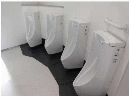
▲H29年度に改修した阿見小学校のトイレ
