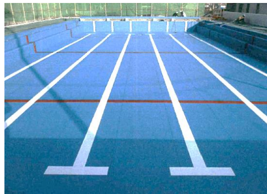
▲H28年度に改修した本郷小学校プール
