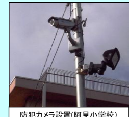
防犯カメラ設置(阿見小学校)
