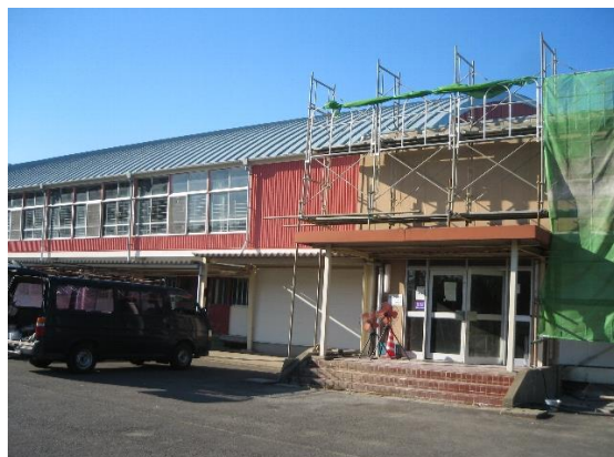
平成24年度に実施している 朝日中学校体育館耐震補強工事
