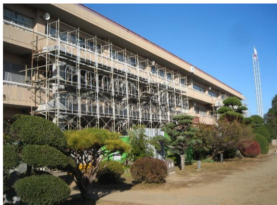
平成24年度に実施している 朝日中学校校舎耐震補強工事
