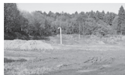
さくらクリーンセンター（最終処分場）
