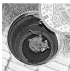
修繕した消火栓
