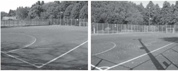
改修工事を予定しているフットサルコート (左：A面全景 右：B面全景)
