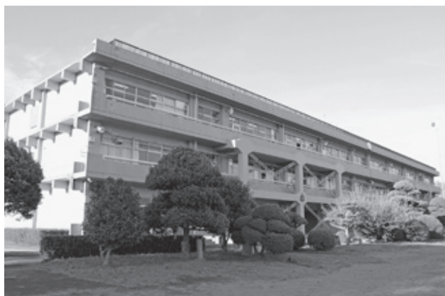
増築工事を予定している朝日中学校
