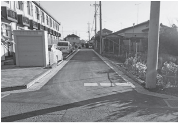
道路改良工事を実施した上本郷地内町道
