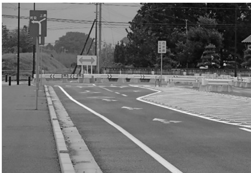
荒川沖・寺子線と寺子・飯倉線の接続付近
