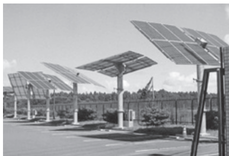
追尾しなかった太陽光発電システム
