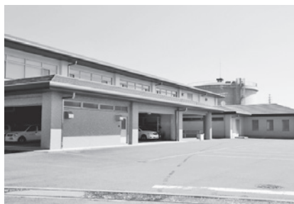
阿見町水道事務所
