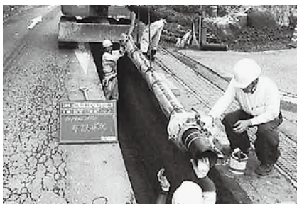
水道管布設工事中
