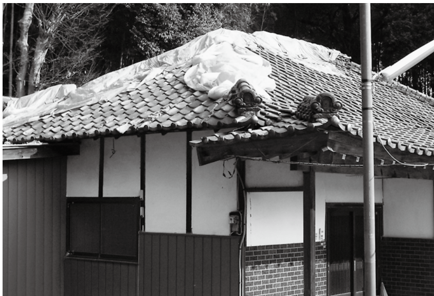
地震災害による被害状況
